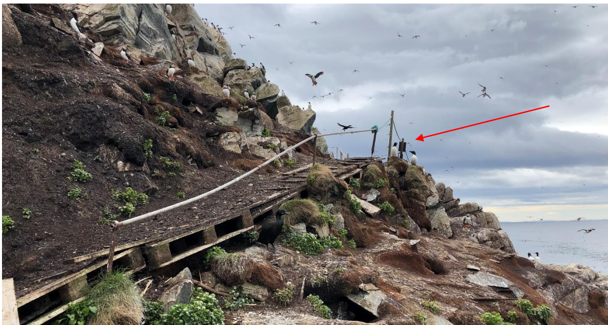
Figur 2 Det skal være oppsatt skilt i begge retninger som viser hvor rasfarlig område befinner seg. Ved ferdsel i det rasfarlige området må ferdselsintruks følges.
