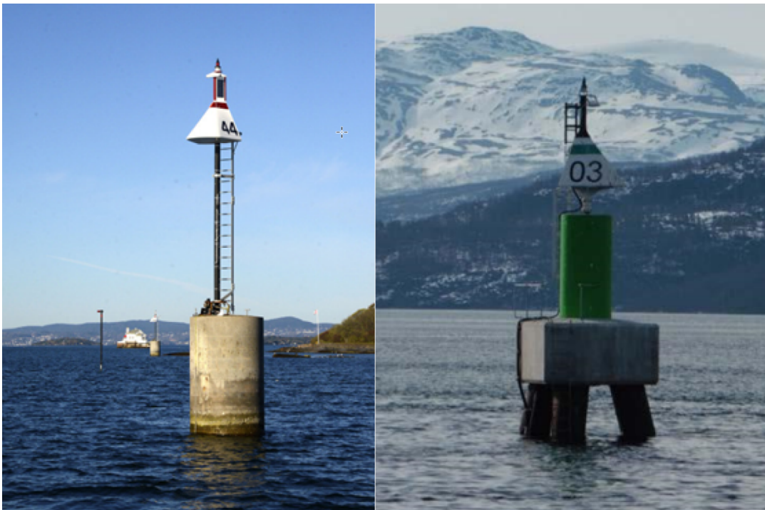
Figur 3: To moglege utformingar av navigasjonsinnretningane i sjø.
